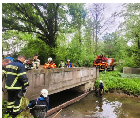
Einsetzen der Balkensperre Foto: Privat
