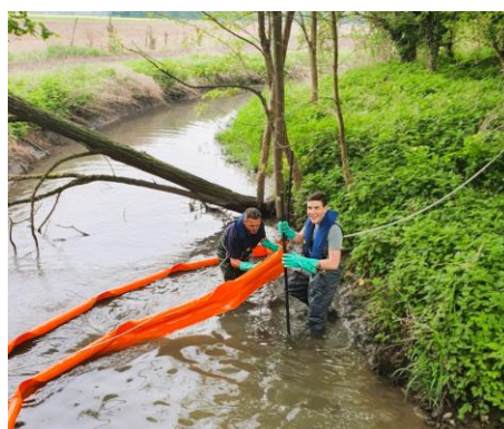
Einsetzen der Schwimmsperre Foto: Privat
